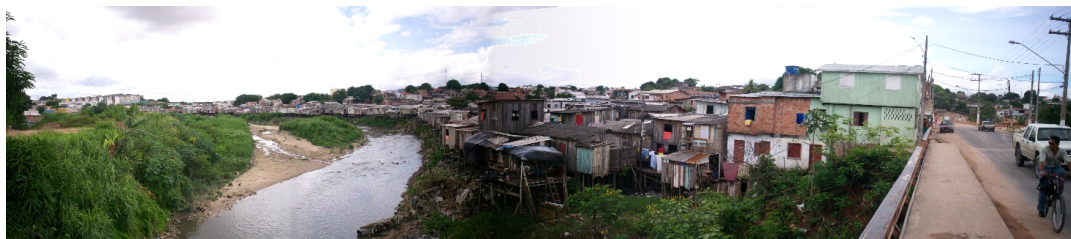
Figura 4- Ocupação de palafitas na margem esquerda do Igarapé do Quarenta junto a foz do Igarapé da Liberdade. Fonte: arquivo pessoal, mar/2007.
